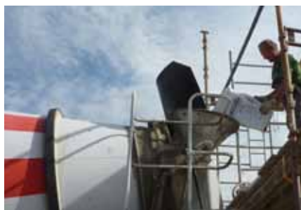
VANDEX AM 10 aggiunto presso lo stabilimento di miscelazione
