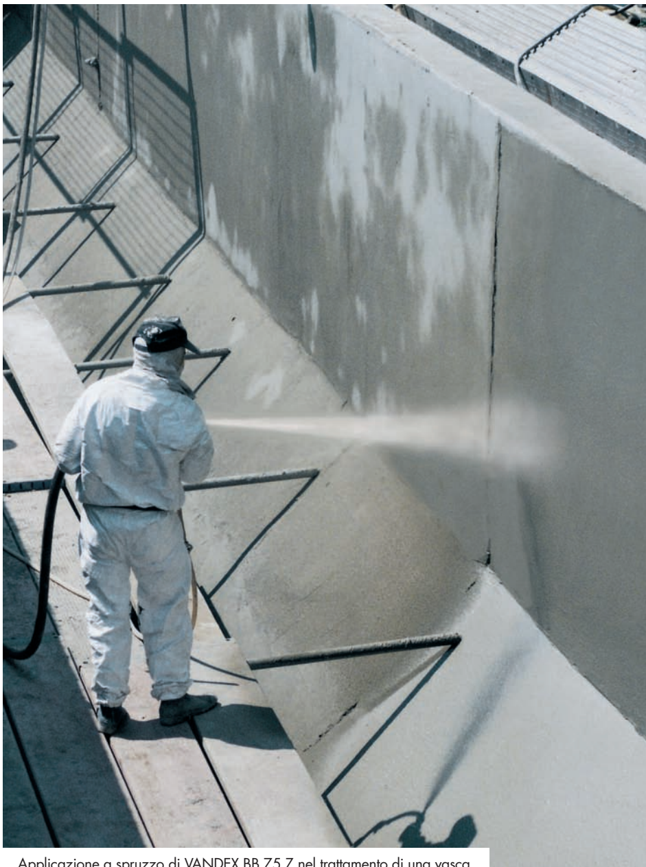
Applicazione a spruzzo di VANDEX BB 75 Z nel trattamento di una vasca.
