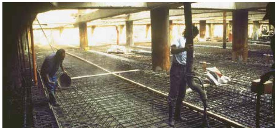
Nel momento in cui **VANDEX SUPER** entrerà in contatto con l'impasto cementizio del getto, verrà assorbito all'interno della capillarità del cemento, formando una barriera impermeabile all'acqua.
