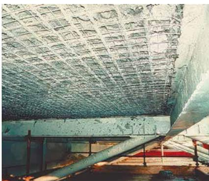
Dopo il corretto posizionamento della rete elettrosaldata, l'operatore provvedeva all'applicazione a spruzzo del 1° strato di 2 cm di **sandtex fixbeton tx**.
