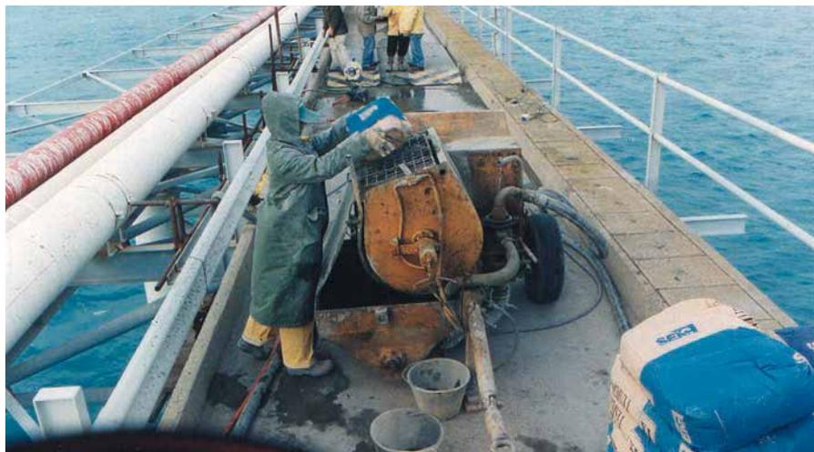
Dettaglio operativo riguardante l'impasto meccanico della malta strutturale fibrorinforzata antiritiro **sandtex fixbeton tx**.
