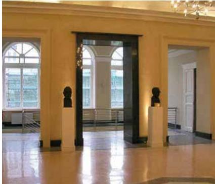
Nel III° livello dove sono ubicati le sale di rappresentanza, è stata effettuata la rasatura delle pareti con l'intonaco traspirante di rasatura **sandtex wallcem grigio**. La finitura è stata realizzata con lo stucco minerale lucido a base di grassello di calce a lunga stagionatura **sandtex epoca spatolato**.
