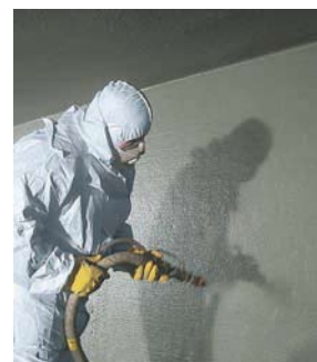
Spruzzatura del rivestimento
