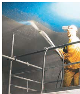
Preparazione del substrato
