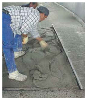
Posizionamento delle guide
