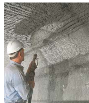
Spruzzatura della malta livellante
