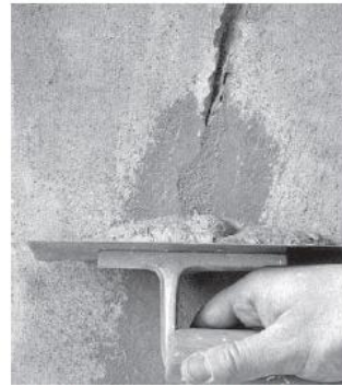
(3) Sigillatura della lesione con sandtex raselast miscelato con cemento
