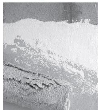
(6) Finitura con sandtex duroflex
