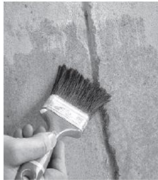
(2) Applicazione di sandtex primer (interni) o sandtex stabilizer (esterni)
