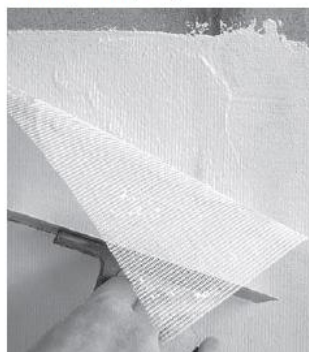
(5) Applicazione di sandtex fibrelast e successiva rasatura con la seconda mano di sandtex raselast
