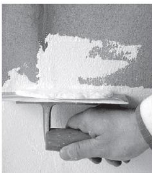
(4) Rasatura totale con una mano di sandtex raselast
